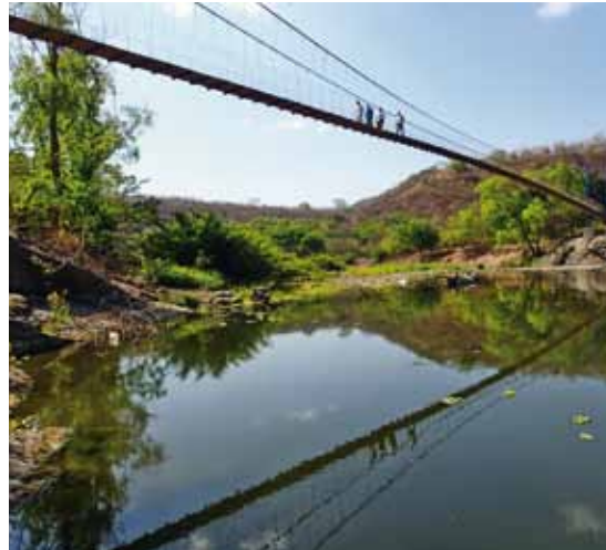
2014 bauten Mitarbeiter von HOCHTIEF Solutions und der Holding eine 54 Meter lange Brücke über den Fluss Kiroenzi in Ruanda (Bild links).
